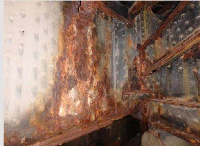
Abb. Mühlentorbrücke Korrosionsschäden an einem Knotenpunkt des Überbaus mit Querschnittsschwächung
