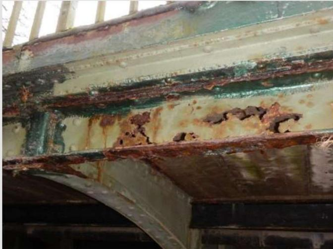
Abb. Mühlentorbrücke Korrosionsschäden an den Gehwegkonsolen (Kragarm) mit Querschnittsschwächung
